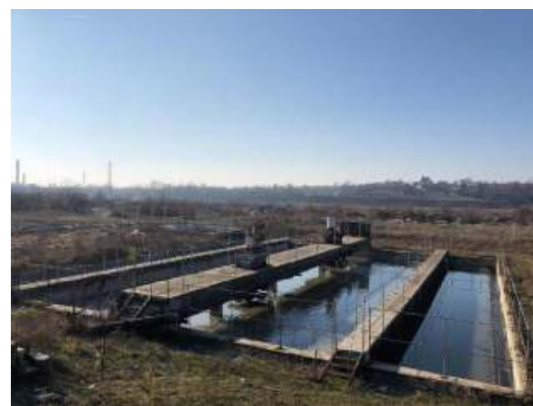
Modernizare și extindere stație de epurare
